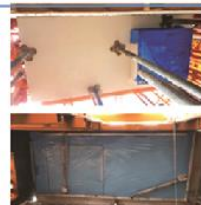
03 고정대(동바리 등) 설치
